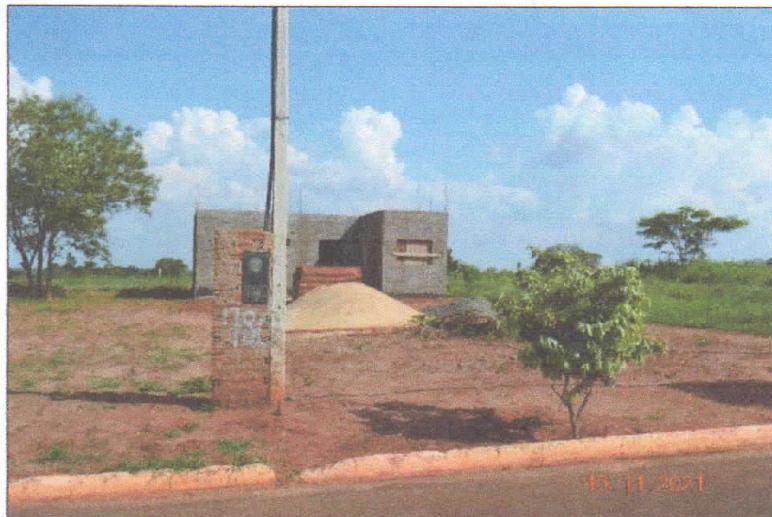
LOTE Nº 27 – RUA JOSÉ OSVALDO PASTORELLI Nº 780 – OBRA IRREGULAR
