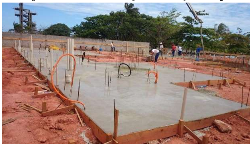
Figura 8 - Radier concretado já com tubulações no lugar
